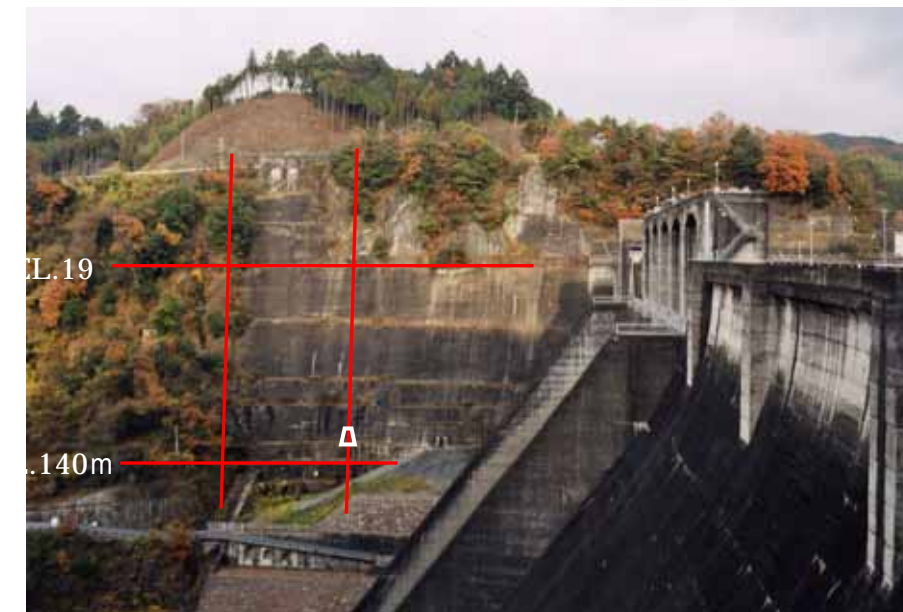
写真 - 3.5.3 右岸全景の現況（平成 14 年撮影）
